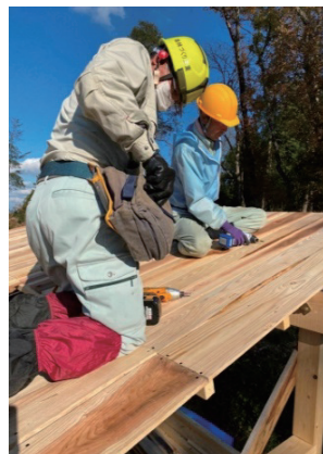
2020.12/5 屋根に野地板を取り付け、天窓も付け、屋根工事完成
