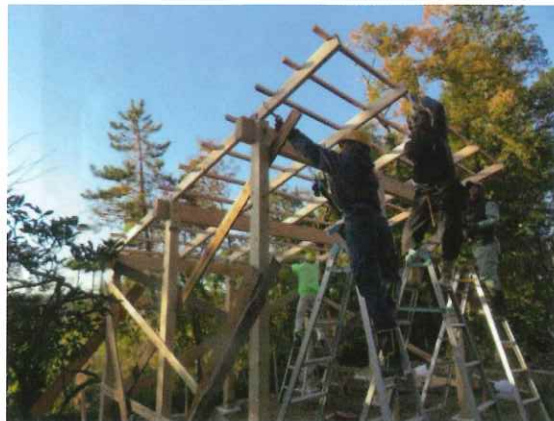
2020.11/21 この日は、柱と桁の組付け作業から始めました。写真は建屋全体を垂木受けや垂木でつなぐ作業。この日で棟上げ完了。
