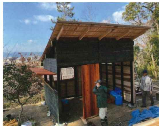
2020.12/23 壁板を取り付け、塗装、建具取り付け、建具開閉調整作業、小屋完成！
