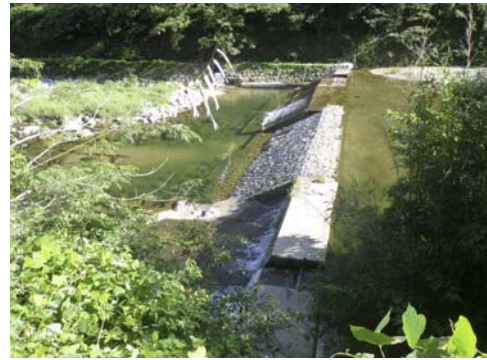
写真4 加太川最下流側のトラップ設置地点
