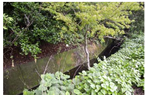
写真1 上流側からみたサニーロード脇の側溝
