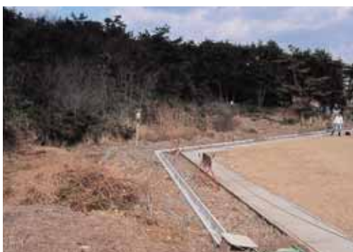
写真2 湿地保全も考慮した排水工事. 2001年1月23日
