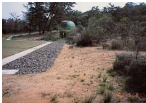
写真1 排水工事施工直後の状態. 2000年5月8日
