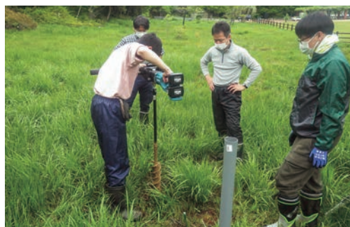
井戸を掘って手前の管を埋め込む
