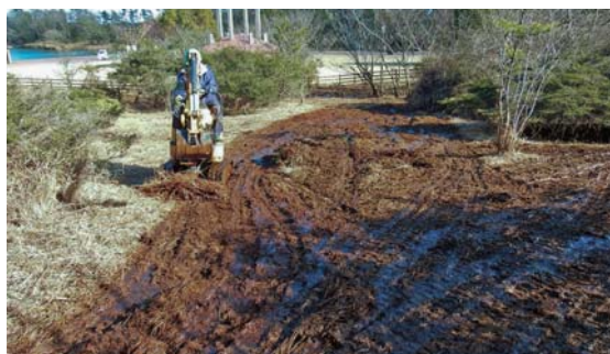
写真3 重機で表層をはがしていく作業
