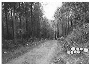
森林作業道の作設
